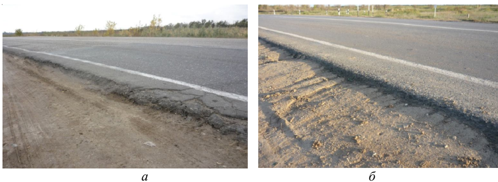
Рис. 3. Превышение кромки проезжей части над обочиной: a – федеральная дорога М-4; б – дорога Волгоград – Астрахань
