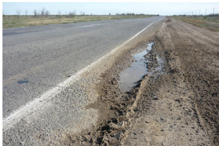
Рис. 1. Просадка укрепленной обочины дороги Волгоград – Элиста
